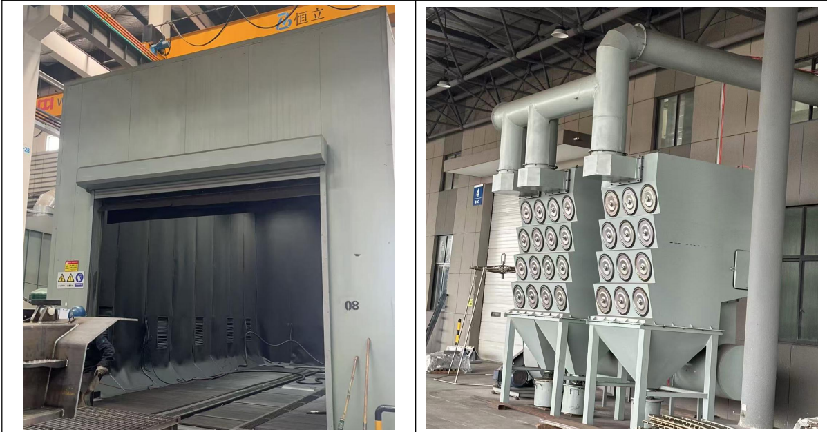
图 4-10 底漆前处理废气（喷砂）收集处理装置
