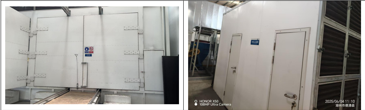
图 4-11 底漆前处理废气（吹灰）收集处理装置
