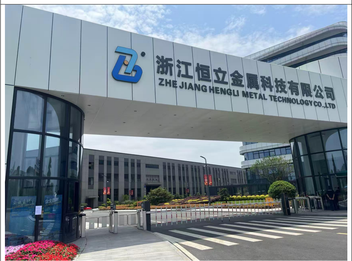
图2 浙江恒立金属科技有限公司环保设施调试公示
