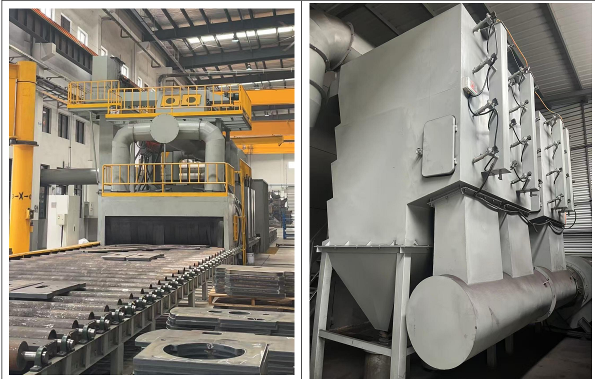
图 4-5 打磨粉尘收集处理装置
